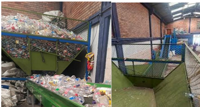
Imagen 12. Silos de almacenamiento
